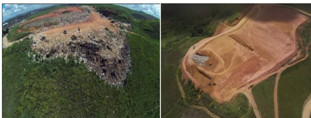
Figura 2: Aterro sanitário do município antes e depois da assinatura do TCA
